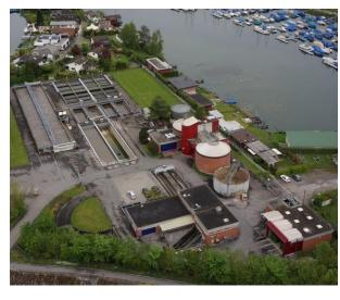
Die ARA Untermarch wurde 1973 als klassische Belebungsanlage mit Tiefenbelüftung in Betrieb genommen. Die Anlage wurde 1985, 1998 und 2005 ausgebaut. 2005 wurde die Abwasserstrasse erweitert und teilweise erneuert. Die Anlage verfügt über eine Kapazität von 42'500 biologischen und 52'000 hydraulischen Einwohnerwerten und einer maximalen Durchflussmenge von 240 l/s.
