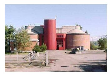
Die ARA Untermarch wurde 1973 als klassische Belebungsanlage mit Tiefenbelüftung in Betrieb genommen. 1985 bis 1998 wurde die ARA erstmalig ausgebaut. Im Berichtsjahr 2005 war ein zweiter Ausbau im Gange. Die Anlage verfügte im Berichtjahr über eine Kapazität von 30'000 biologischen und 52'000 hydraulischen Einwohnerwerten.
